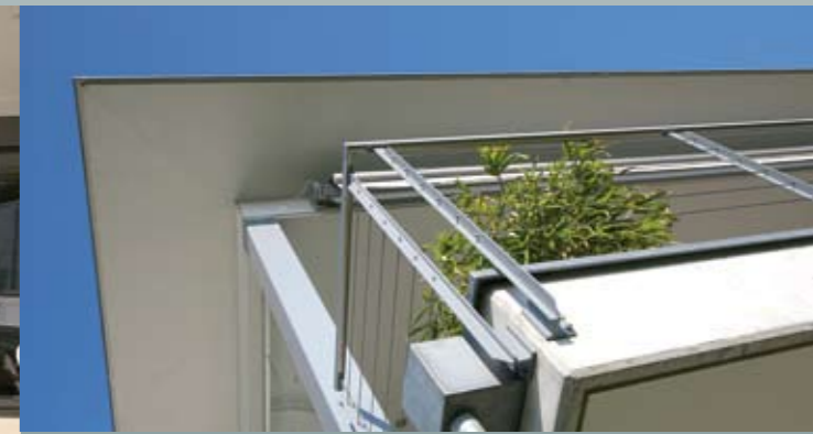
83 08 30 VA Seil ø 5mm 80 10 12 VA Endhülse mit Aussengewinde M5 83 09 55 VA Hutmutter M5 83 09 58 VA Unterlegscheibe ø 5,3mm
